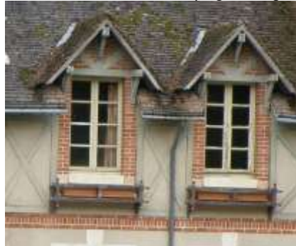
Lucarnes de l'annexe (lingerie-logement)
