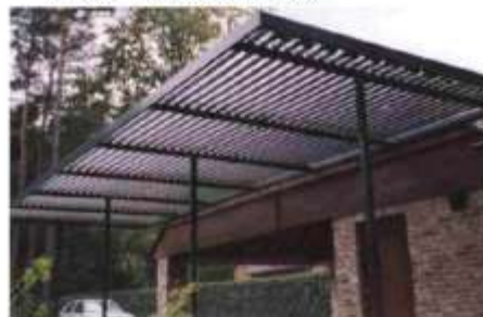
Création d'une pergola pour accueillir des panneaux thermiques
