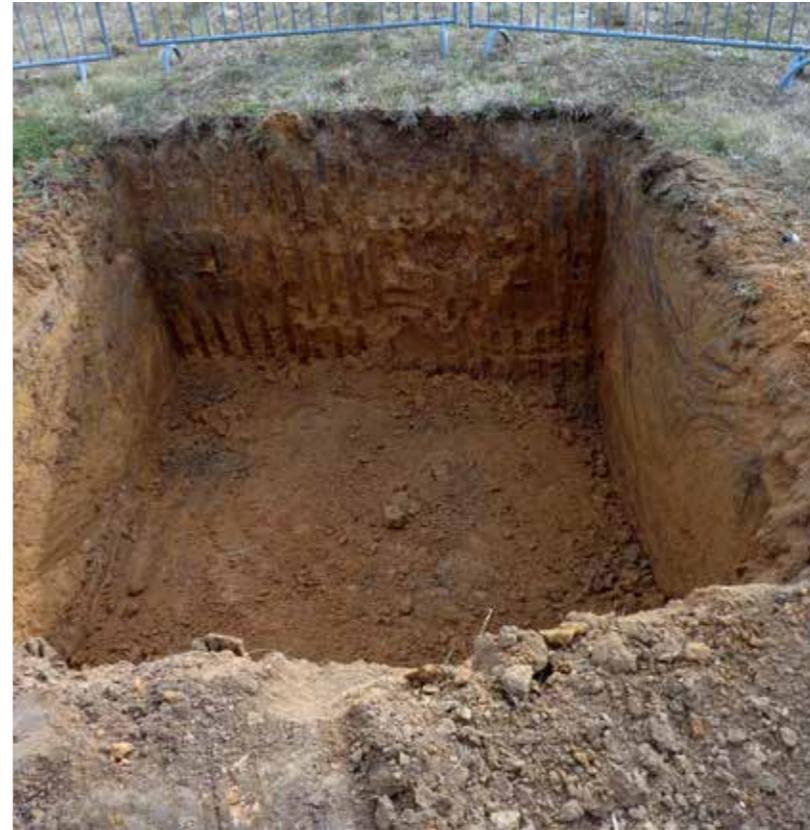
La coulée sur place nécessite de creuser une fosse de 3 mètres de profondeur. Dès jeudi 30 août après-midi, le déchargement du moule, fabriqué préalablement à la fonderie de Strasbourg constitue la première opération sur site, avant l'excavation du terrain.
